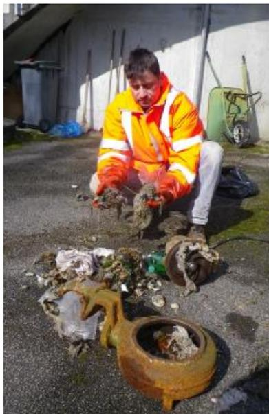
Le délestage de lingettes (même biodégradables), de bouteilles, d'huiles de vidanges, obstrue les canalisations et bloque les pompes de relevage.
